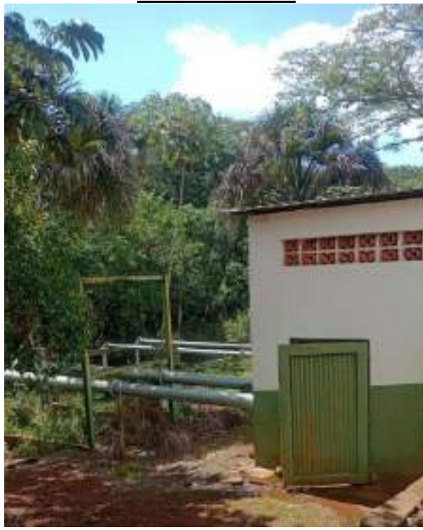
CASA DE BOMBA
