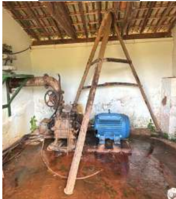
CASA DE BOBINA DO PIVÔ
