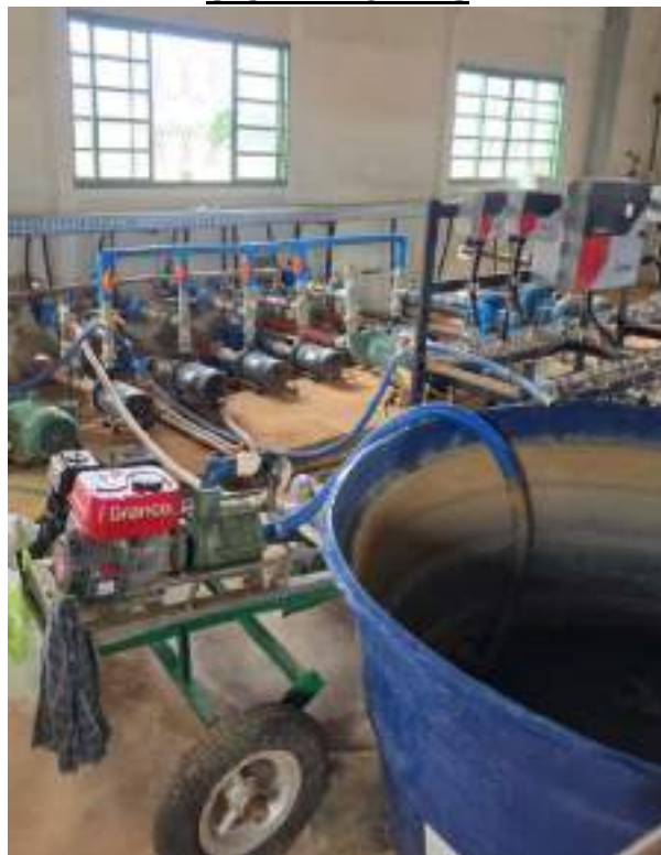
CASA DE BOMBAS
