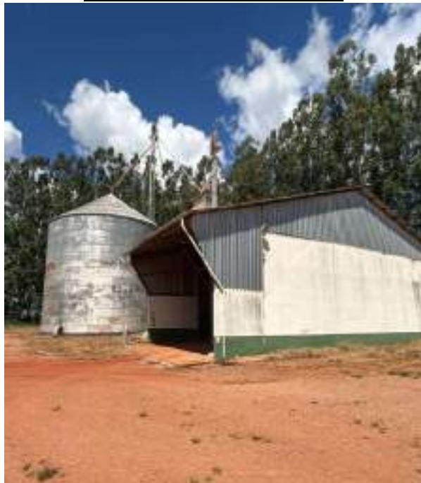
SILO DE ARMAZENAMENTO
